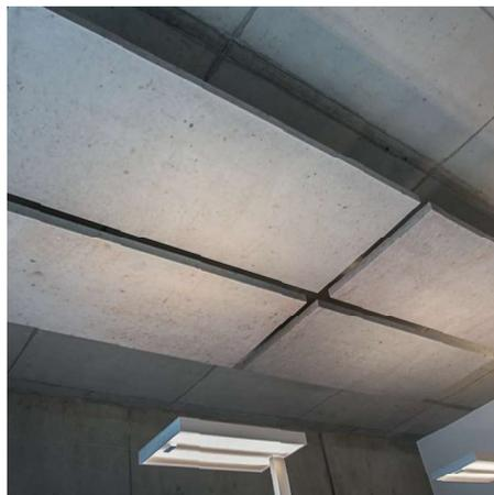
Aufgrund der hohen Schallabsorption des Deckensegels sind – abhängig von den Rahmenbedingungen – oftmals nur Teilbereiche einer Deckenfläche zu bestücken. Die Absorptionsleistung der vorhandenen Decke wird erhöht, die Nachhallzeit reduziert. Das **CeilingCube Deckensegel** ist ein Absorber der Klasse A.
